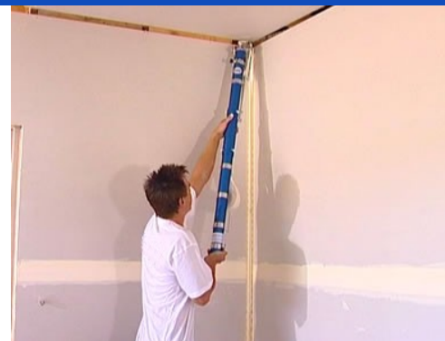
Applicazione carta e stucco Plastermix su angolo interno*
