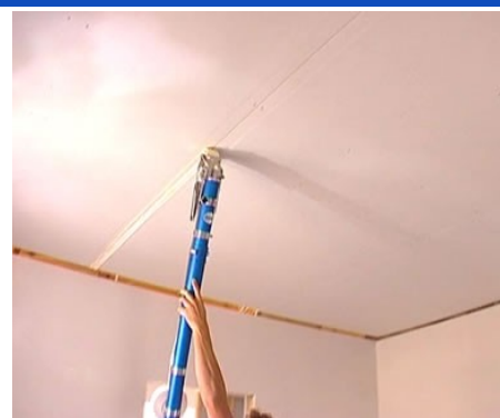
Applicazione carta e stucco Plastermix su giunto a soffitto °
