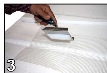
3 Mediante la spatola sagomata art. 498, si riesce ad affogare la rete già sagomata art. R/OMEGA con la colla art. REKOLL/08 nel canale.
