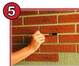
5 Lasciare le fughe con un pennello umido, assicurandosi che le fasce di Brick Flex siano completamente incollate.
