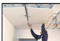
**Set per il posizionamento e fissaggio di lastre in cartongesso**
