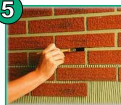
Lisciare le fughe con un pennello umido, assicurandosi che le fasce di Brick Flex siano completamente incollate.
